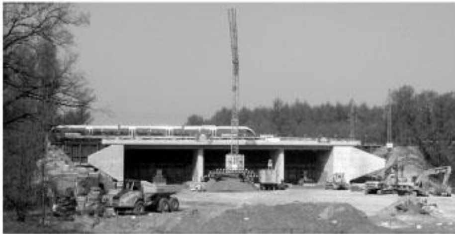
Die A33 unterquert in der Nähe der Winterstraße die große Bahnlinie zwischen dem Ruhrgebiet und Hannover. Brücke und Autobahn werden ohne Unterbrechung des Bahnverkehrs realisiert. Foto: Thomas Kiper
